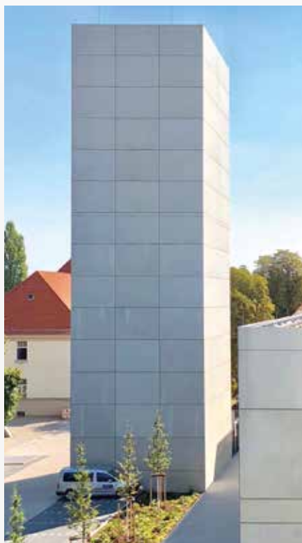
Turm des Einstein-Elevators am Hannover Institute of Technology der Leibniz Universität Hannover
